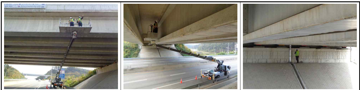
[고소작업차를 이용한 근접조사 실시]
