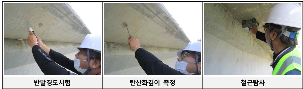
[그림 14.3.1] 비파괴시험 수행 사진
